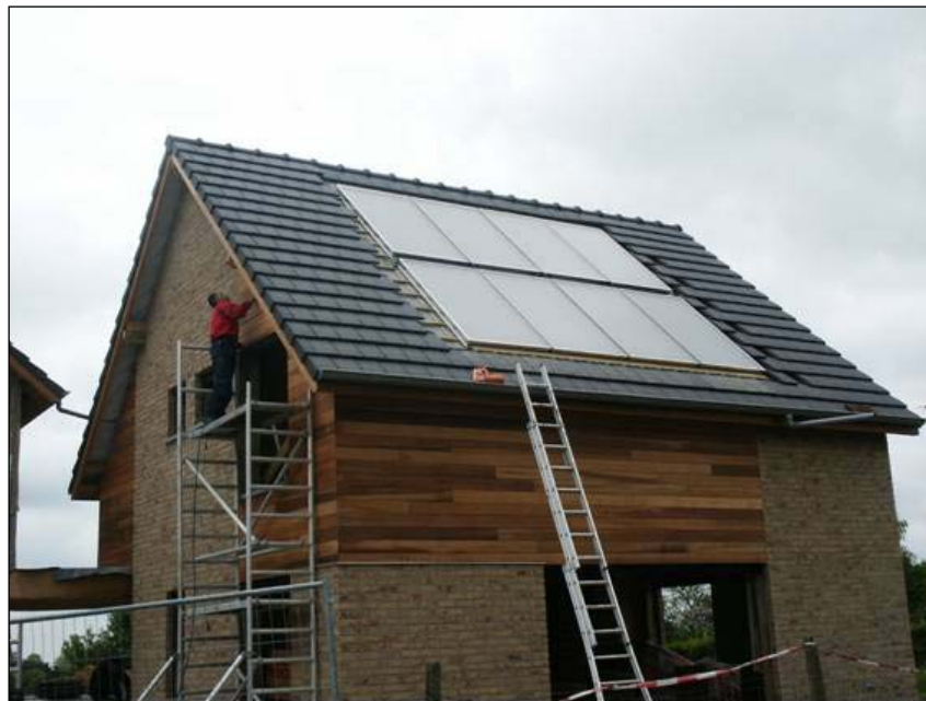
Figure : Photo d'un CES en cours d'installation en toiture (16 m 2 ) (source : APERE © )
