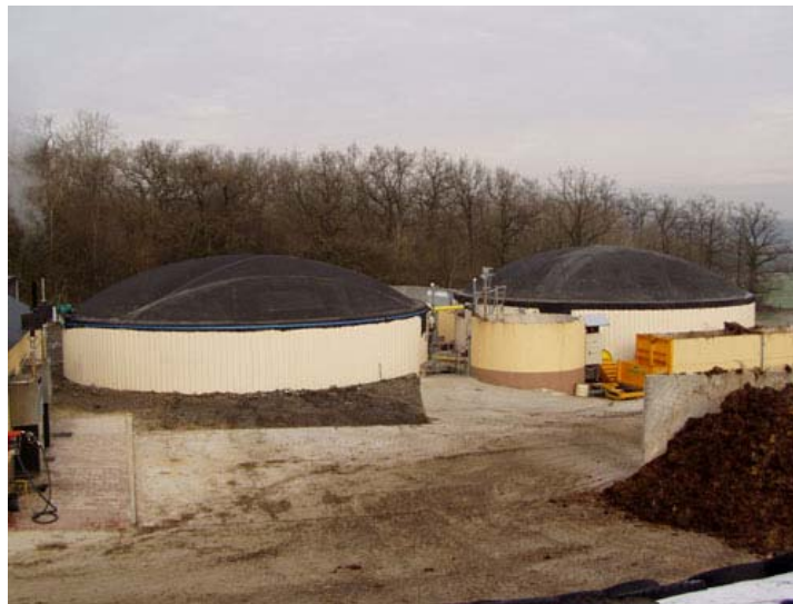
Figure : L'unité de biométhanisation de la ferme du Faascht (Attart) (source : ValBiom)
